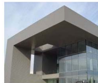
Edificio de oficinas de Video Mercury Films
